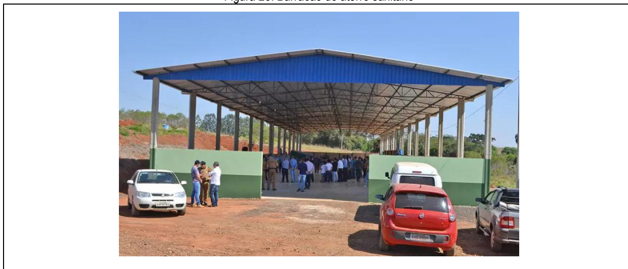
Figura 25: Barracão do aterro sanitário
