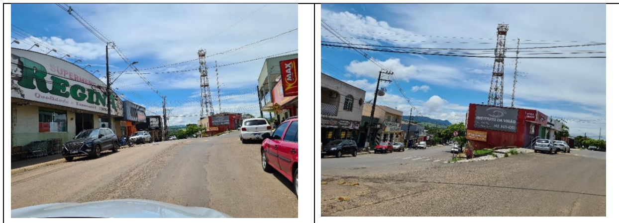
Figura 28: Vista de torre de comunicação na sede urbana
